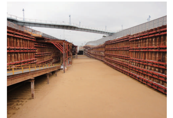
この後、道路や壁がつくられ、高速道路になりました
