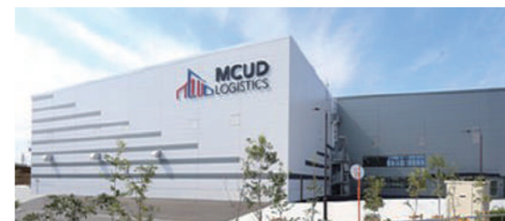
やちよぶつりうしせつ 八千代物流施設
