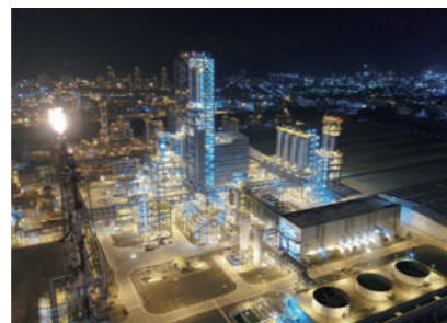
ポリエチレンプラント (インドネシア)
