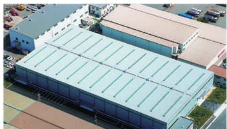
日鉄物産の工場 建物の屋根
