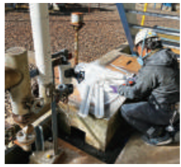
断熱材の取り付け作業を行います。
