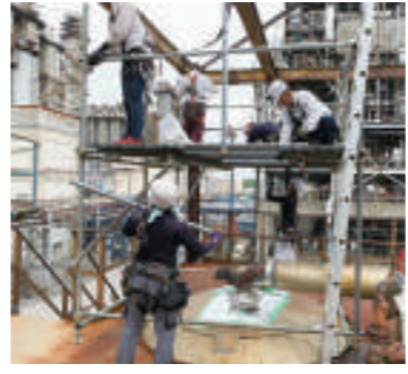
高く手が届かない所や足場がないと工事ができない所に、作業床を設置します。
